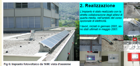
Fig. 6: Impianto fotovoltaico da 1kW: vista d'insieme (sopra) e componenti principali (a destra)
