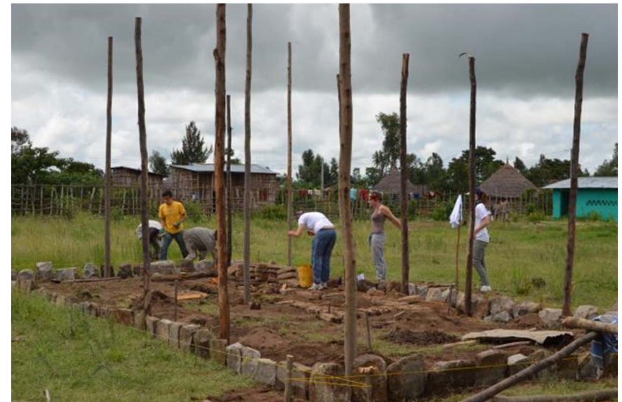
Le fondazioni, la massicciata, la struttura verticale
